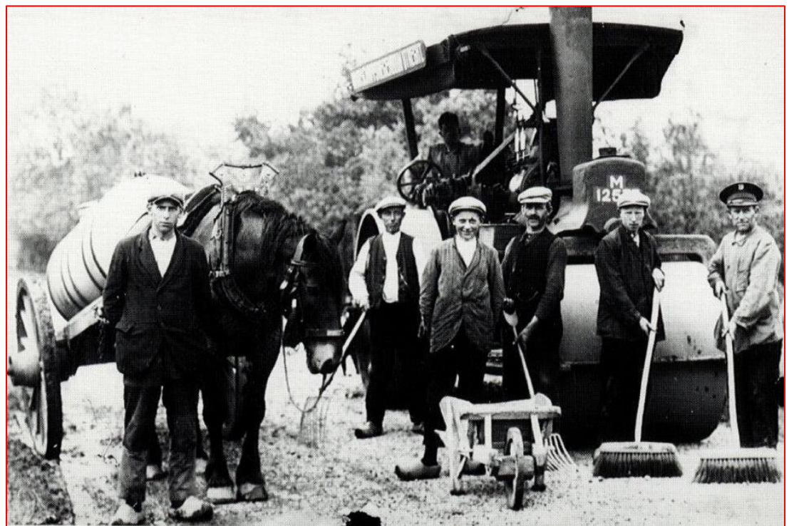
Boven; De 15 tons wegaanrijder tijdens het verharden of repareren van de Deurneseweg in Oploo. V.l.n.r. Jan Weemen, Piet Verberkt, Gerrit Erkelens, Tien Verberkt en Koos Erkelens.
